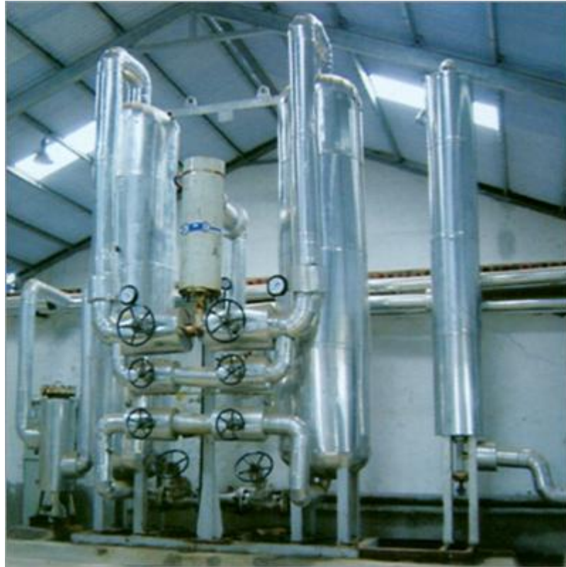
شکل ۴- بخشی از واحد تولید اکسیژن، نیتروژن و آرگون
